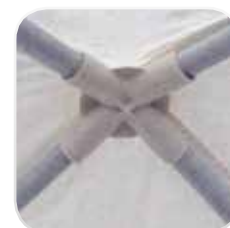
Articulació de les barres metàl·liques al sostre
